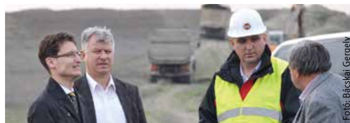
A nyomvonal kijelölésével, a föld mozgatásával megkezdődtek a munkálatok
