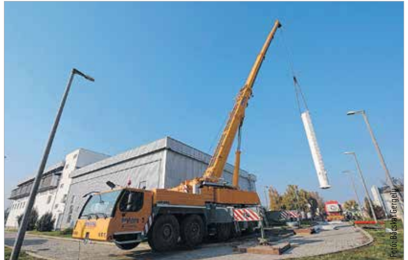
A kazán elemeit kétszázötven tonnás daruval emelték a helyükre
