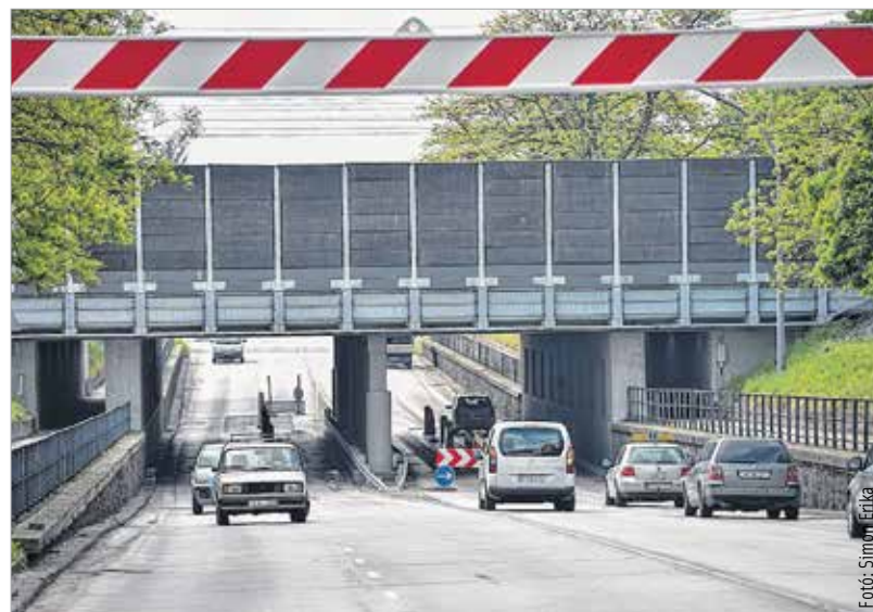
Az aluljáróban már nincs sávlezárás – felújítási munkálatai április végén befejeződtek
