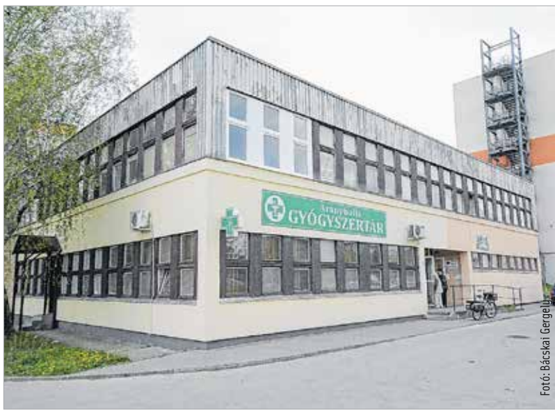
A Verseci utcaival kezdődhet a városi rendelő felújításának sora
