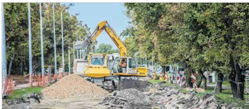
Az útfelújításokkal egy időben a közműfelújítást is elvégzik a szakemberek
