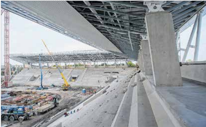
Tető van a fejünk fölött, és már szerkezetkészek a lelátók – kezdődhet a székek szerelése!
