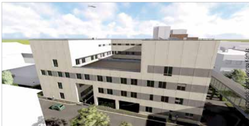
A Modern Városok Program keretében megvalósuló új belgyógyászati tömb tizenkétezer négyzetméteres lesz
