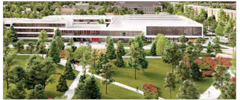
A középiskolai campus projektjének első ütemében hamarosan elkezdik a Vasvári gimnázium új épületének építését és a Kodolányi középiskola felújítását
