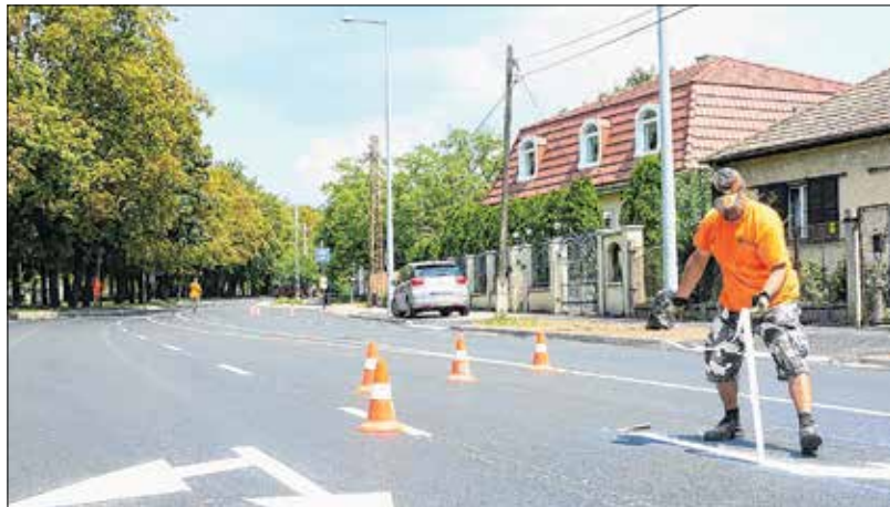
A Géza utca felújítása a múlt héten készült el
