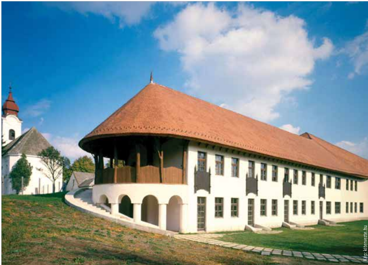
A Sajnovics János Általános Iskola Tordas legszebb épülete, mely Tamás Gábor építész-mérnök tervei alapján épült 1989-ben
