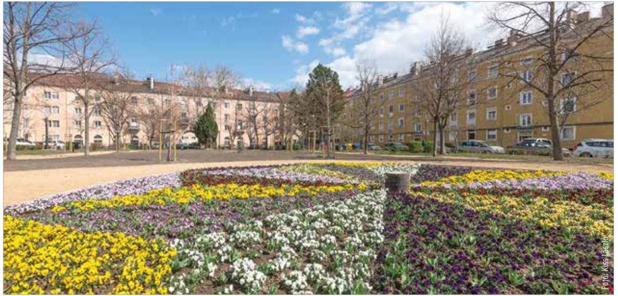
A téren a burkolatra és a növényzetre is ráfért a felújítás
