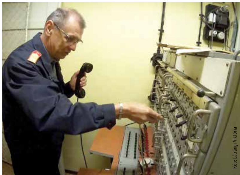
„Ez a kurbilis készülék kapta a hívást. Utána kijelölték, hogy kivel akarnak beszélni, és átadták a vonalat.” – ismertette a ma már ipari műemléknek tekinthető telefonközpont működését Nagy Lajos
