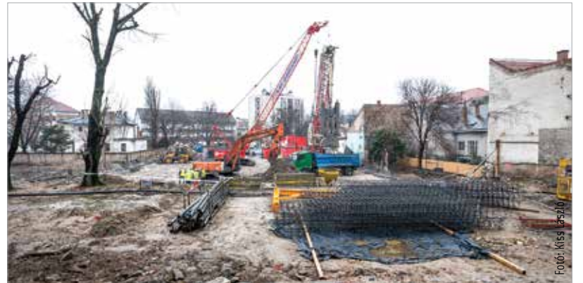
A novemberben kezdett és december végén befejezett bontás után már a mélyalapozásnál tart az intézmény új szárnyának kialakítása
