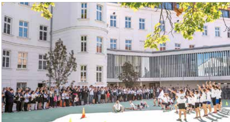
A közel kétmilliárd forintos beruházás során öt új és három teljesen felújított tanterem készült el, valamint egy új építésű tanári szobával és a legkorszerűbb technikával felszerelt aulával bővült az épület
