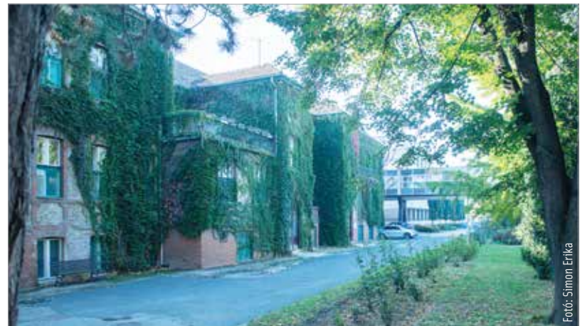
A régi épületet elbontják, és itt kap helyett az új belgyógyászati tömb
