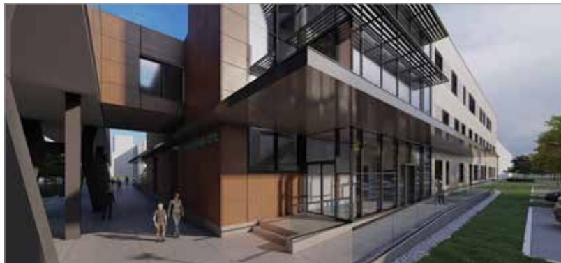
Az épületben egy- és kétágyas, akadálymentesített kórtermek lesznek önálló vizesblokkal. Az épület kórházon belüli elhelyezése, valamint a felújításra kerülő függőfolyosó közvetlen kapcsolatot biztosít majd a többi egységgel.
