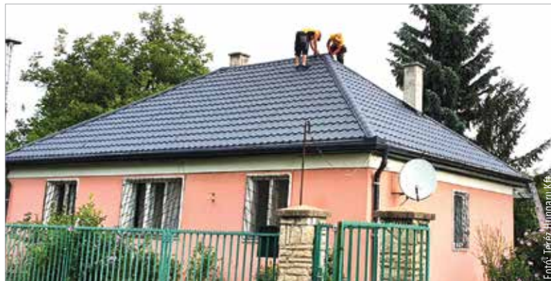
Régi ház, új tető, alpinista technikával, állványozás nélkül
