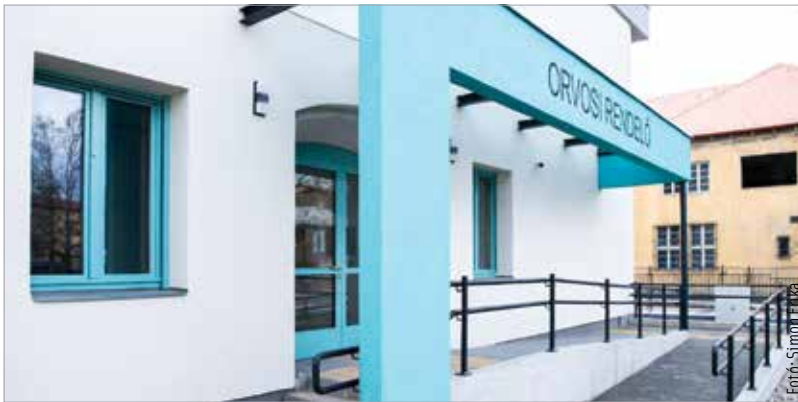
Teljesen megújult és a tetőtér beépítésével ki is bővült a Szekfű Gyula utcai rendelő épülete
