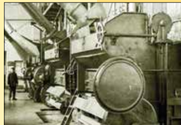
Az első kazánok az eróműben – Koncz Dezso műszaki igazgató gyűjteményéből
