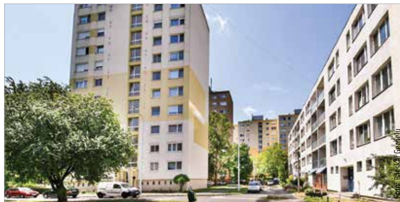
Az elmúlt időszakban ötven helyszínen adtak át út-, járda- és parkolófelújításra munkaterületet a Saára Gyula Útfelújítási Program keretén belül
