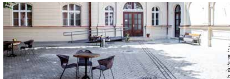
A belső udvarban majdnem teljesen levették a vakolatot, hogy biztosítsák a kiszáradást
