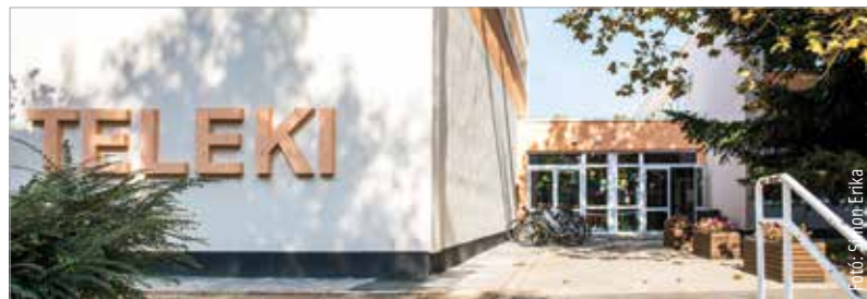
Az intézményfelújítások folytatódhatnak. Néhány héten belül kezdődik a munka a Hétvezérben és az Arany János iskola vízvárosi épületében.
