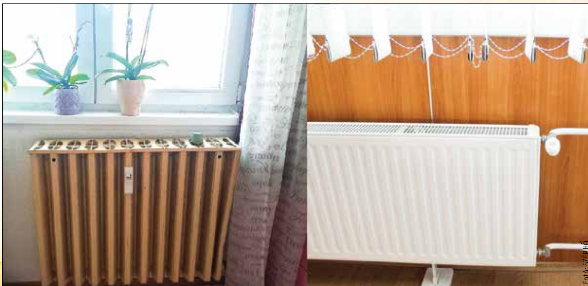
Az átalakításnál, radiátorcsereknél körültekintően kell eljárni, hiszen ezek a beavatkozások hatással vannak a többi lakás fűtésére is!
